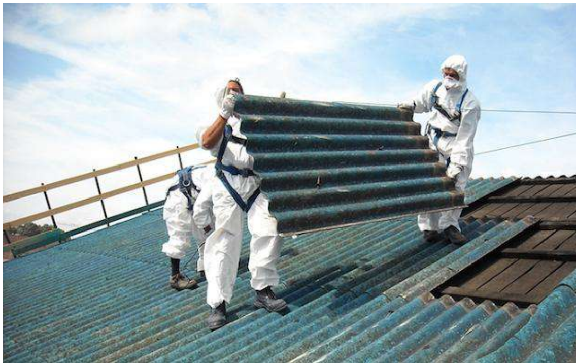
Figura 2: rimozione dell'amianto
