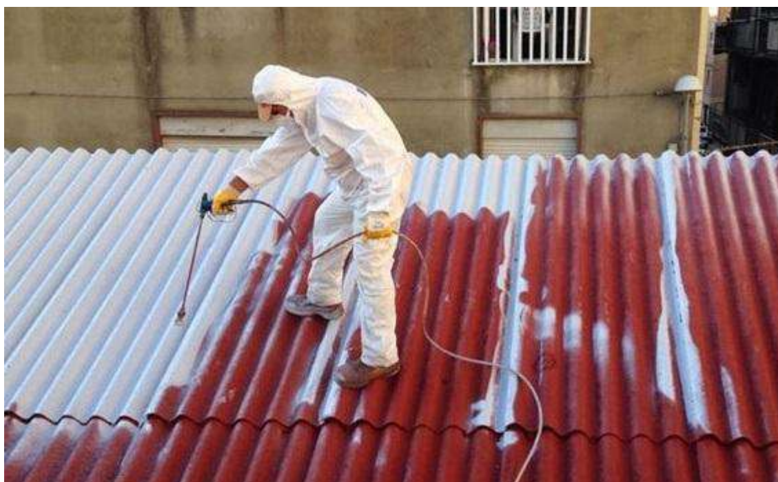
Figura 1 incapsulamento e rimozione di pannelli di cemento amianto
